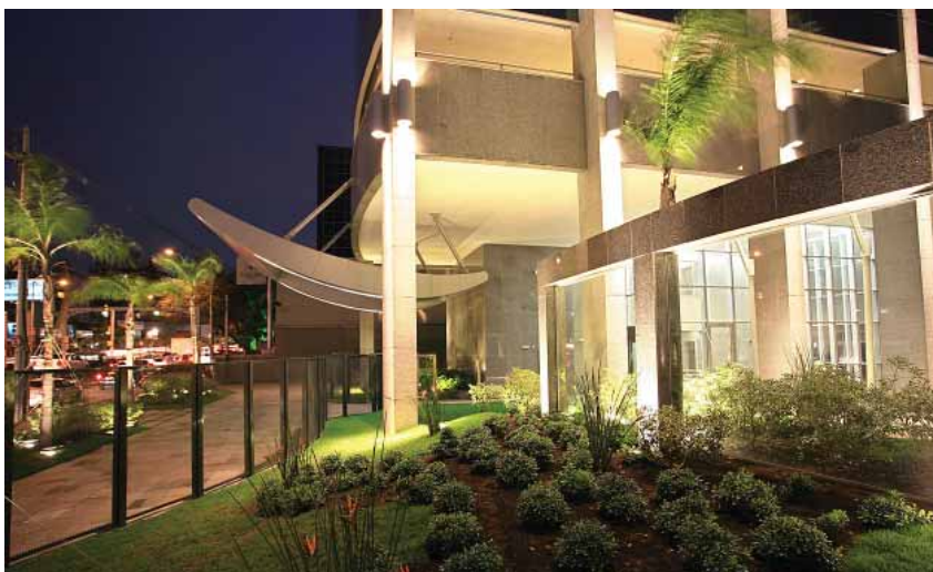
Prédio-inteligente do CIEE-RS tem infraestrutura tecnológica
